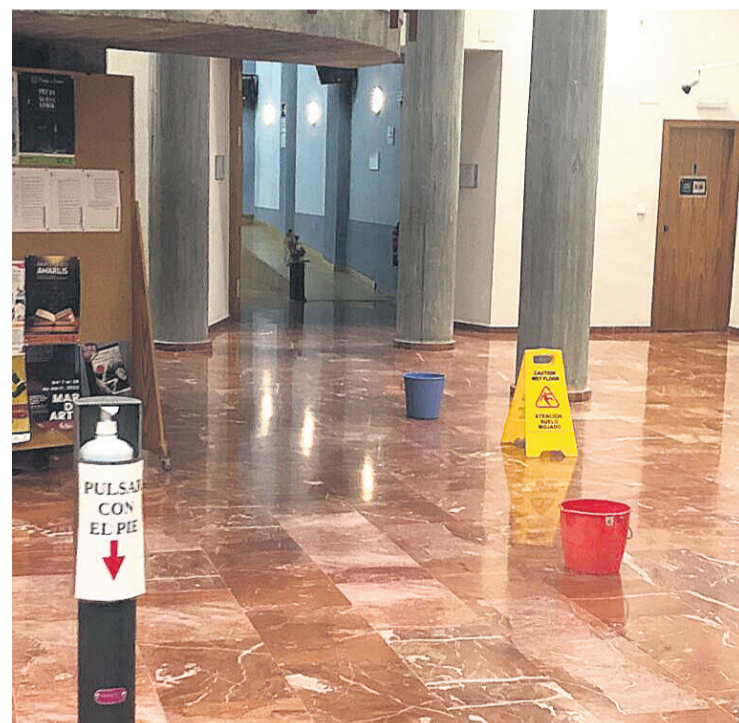
Imagen de la Biblioteca con cubos en el suelo
