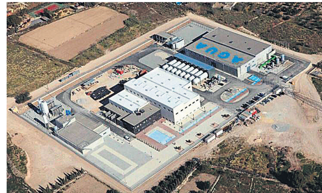
Desalinizadora de Mutxamel
