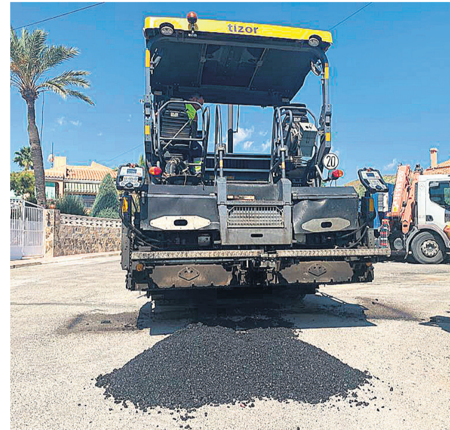
Maquinaria de asfaltado en los trabajos
