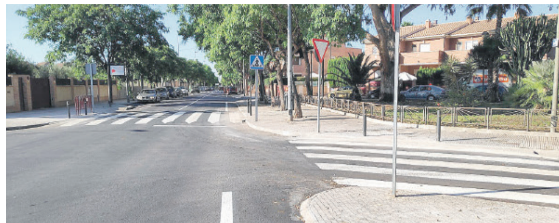
Con la finalización de las obras se mejora la movilidad en Avenida de Benidorm
