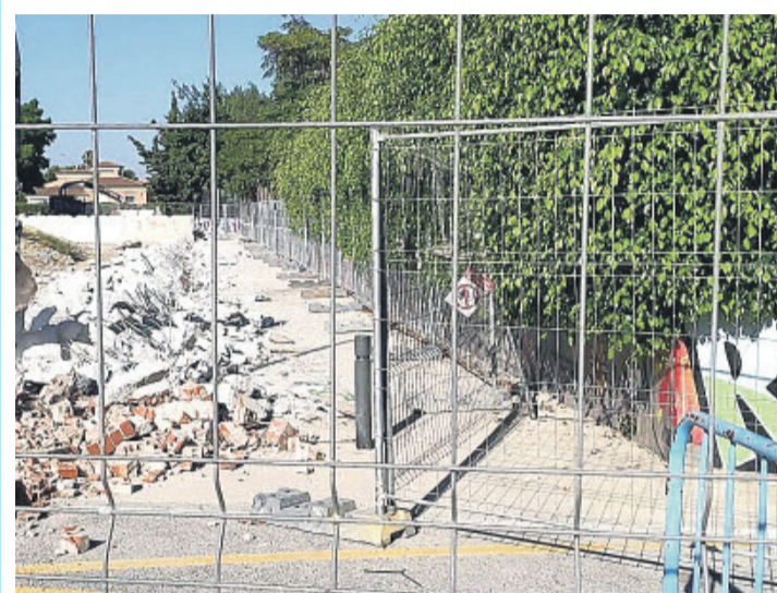
Imagen de las obras
