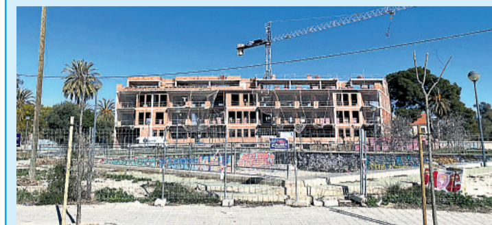
Imagen de uno de los edificio en obras
