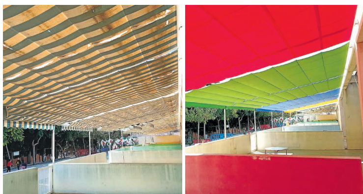
Imágenes de algunos trabajos realizados por Toldos Vicente (Antes y después)
