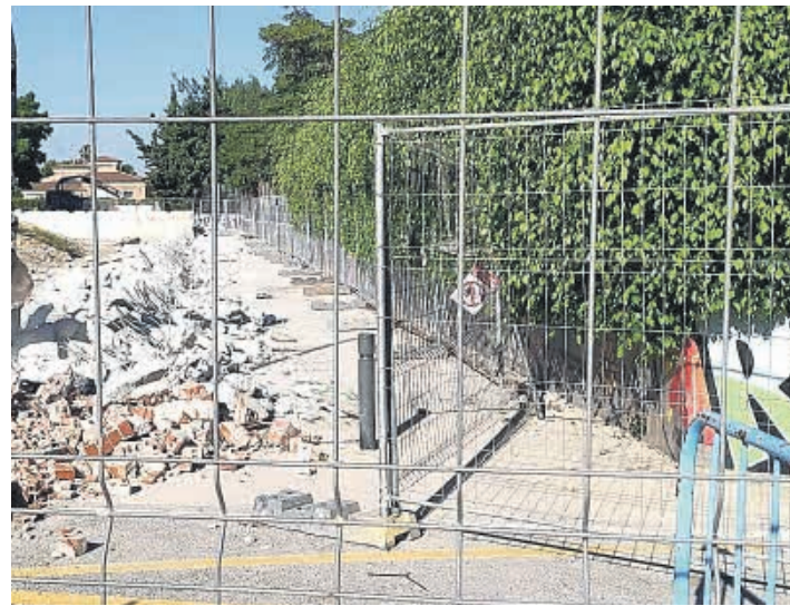
Imagen de las obras
