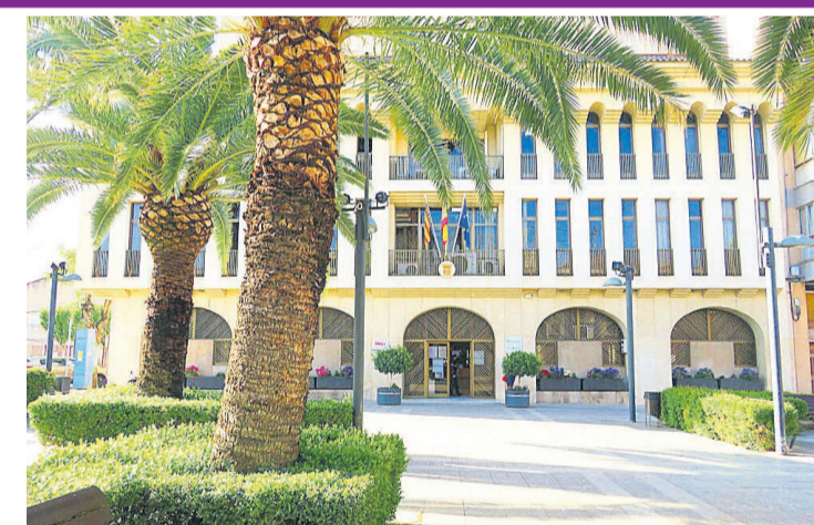
Fachada del ayuntamiento de Sant Joan
