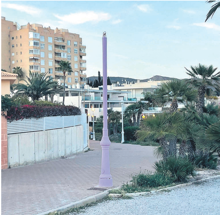
Una de las farolas en mal estado de la zona
