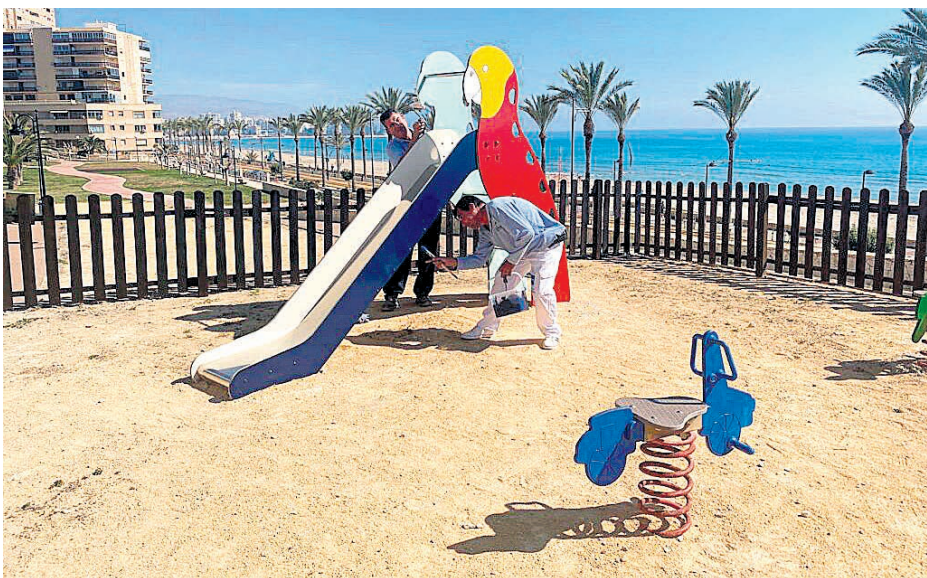
Operarios del Ayuntamiento haciendo trabajos de repintado en el parque
