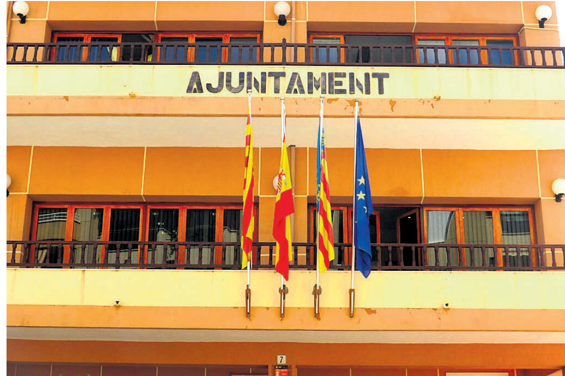
Fachada del Ayuntamiento de El Campello
