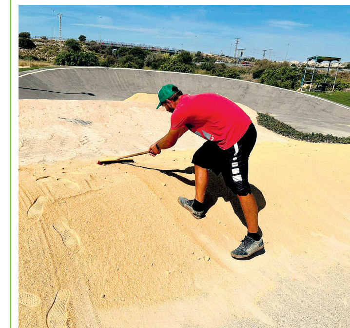
Operario en la pista
