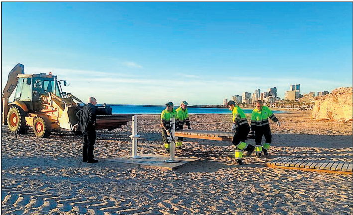
Los operarios del ayuntamiento colocando las pasarelas
