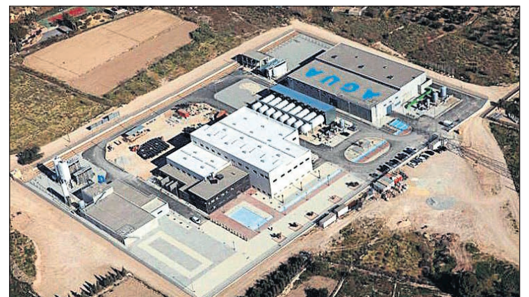
Desalinizadora construida en Mutxamel
