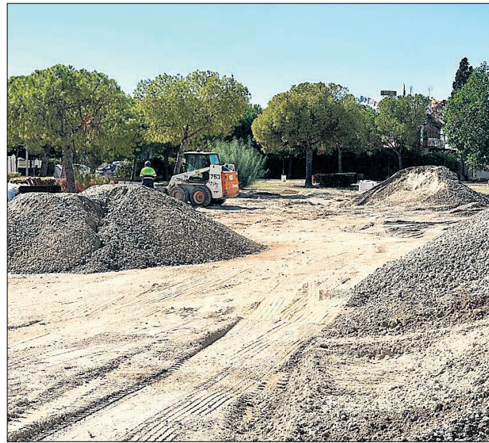
Obras en la pista de Albayna
