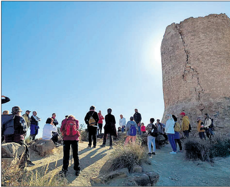
Imagen de la salida a la Torre de Reixes para reivindicar su conservación
