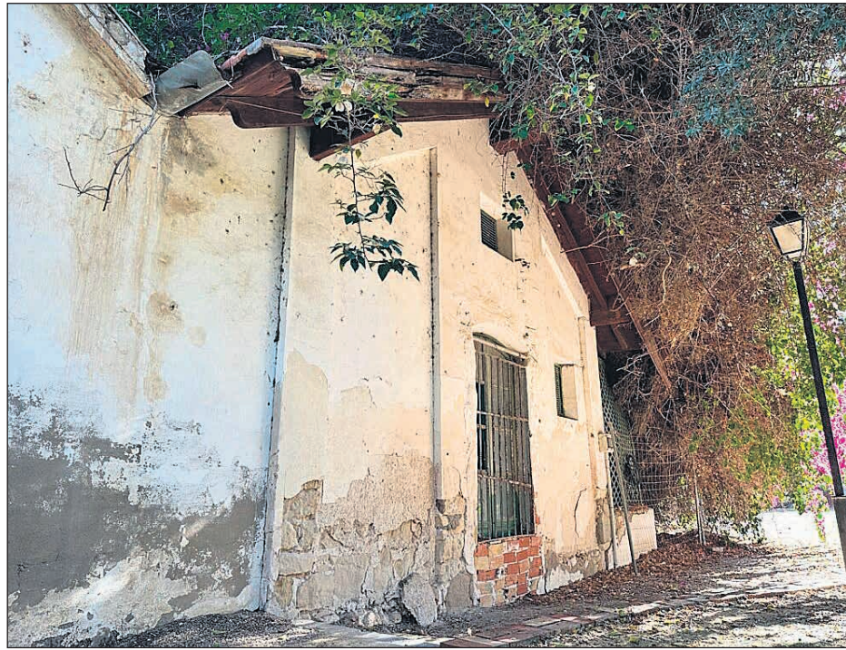
Casa de los Guardeses de Villa Marco
