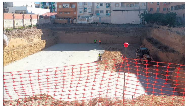
Hormigonado plaza Gabriel Miró
