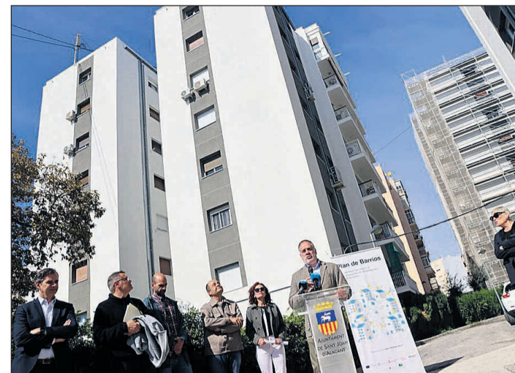
Los bloques A y B ya están finalizados
