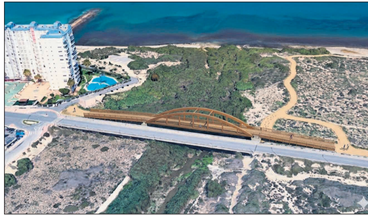
Recreación de la pasarela que se instalará en El Campello
