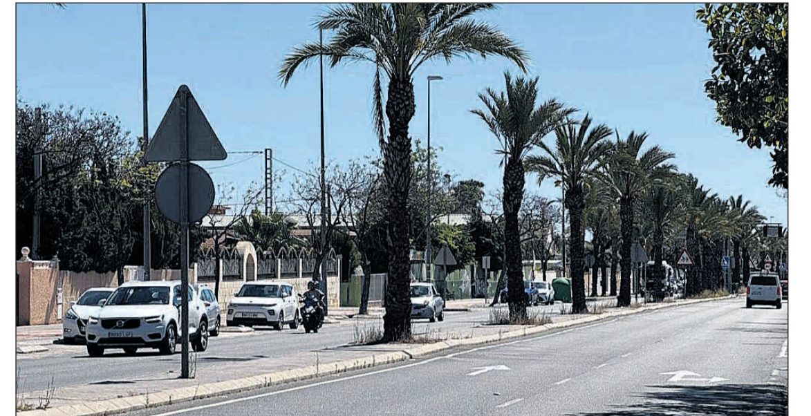
Esta intervención forma parte de las labores de conservación, adecuación y mantenimiento de la red de infraestructuras de transporte de la Generalitat
