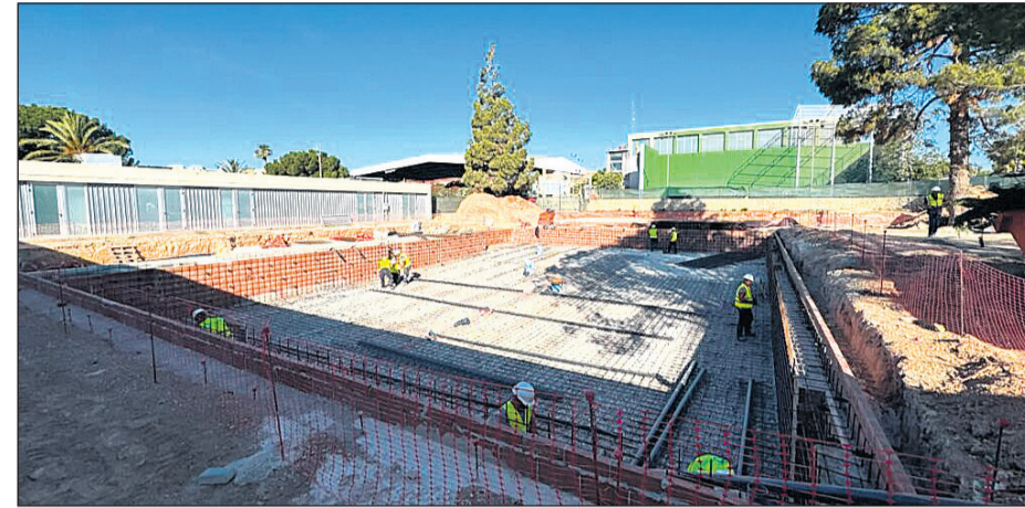
Entre finales de agosto y principios de septiembre comenzarán las labores de cimentación
