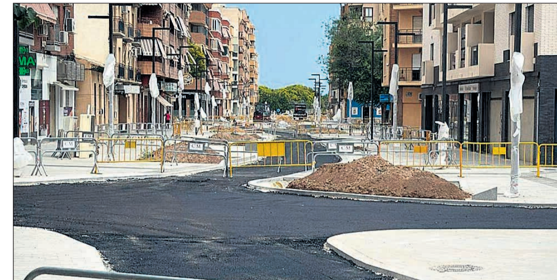
Las obras de remodelación de la calle Villafranqueza emprenden su fase final
