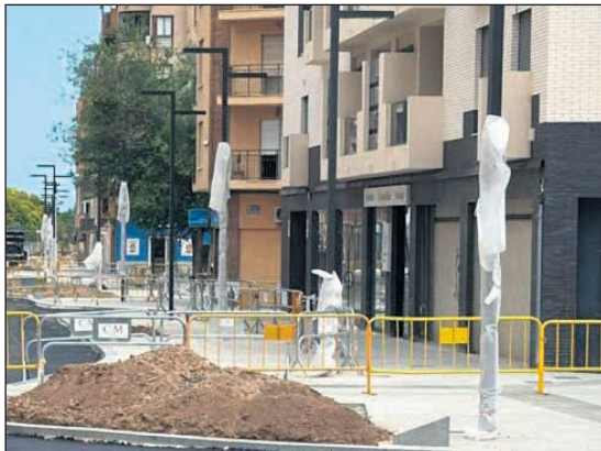
La calle Villafranqueza en obras
