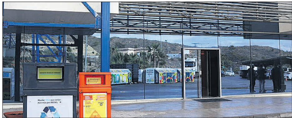
Planta exterior de la planta de residuos
