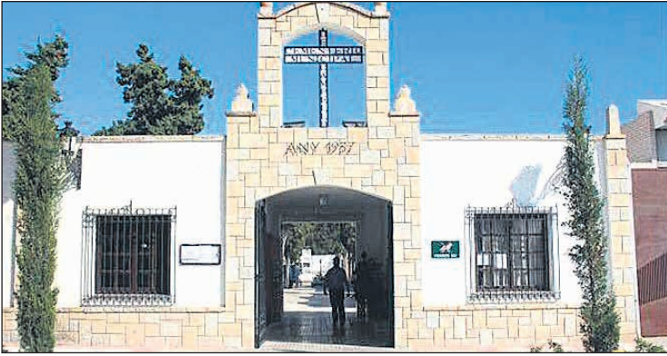
Fachada del Cementerio Municipal de El Campello
