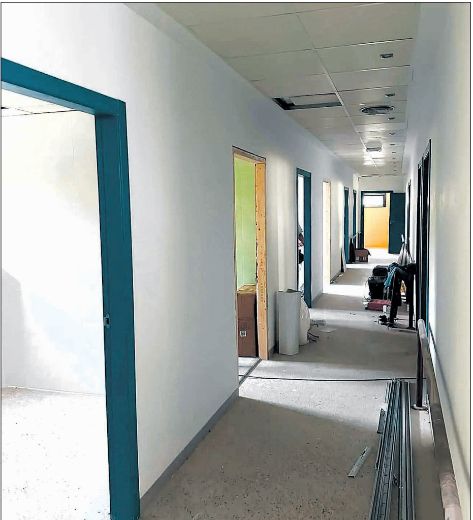
Las obras de adecuación de la Casa Sant Pere ya están en marcha
