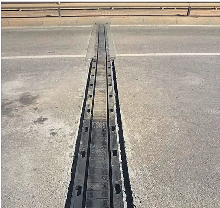
Juntas de uno de los puentes
