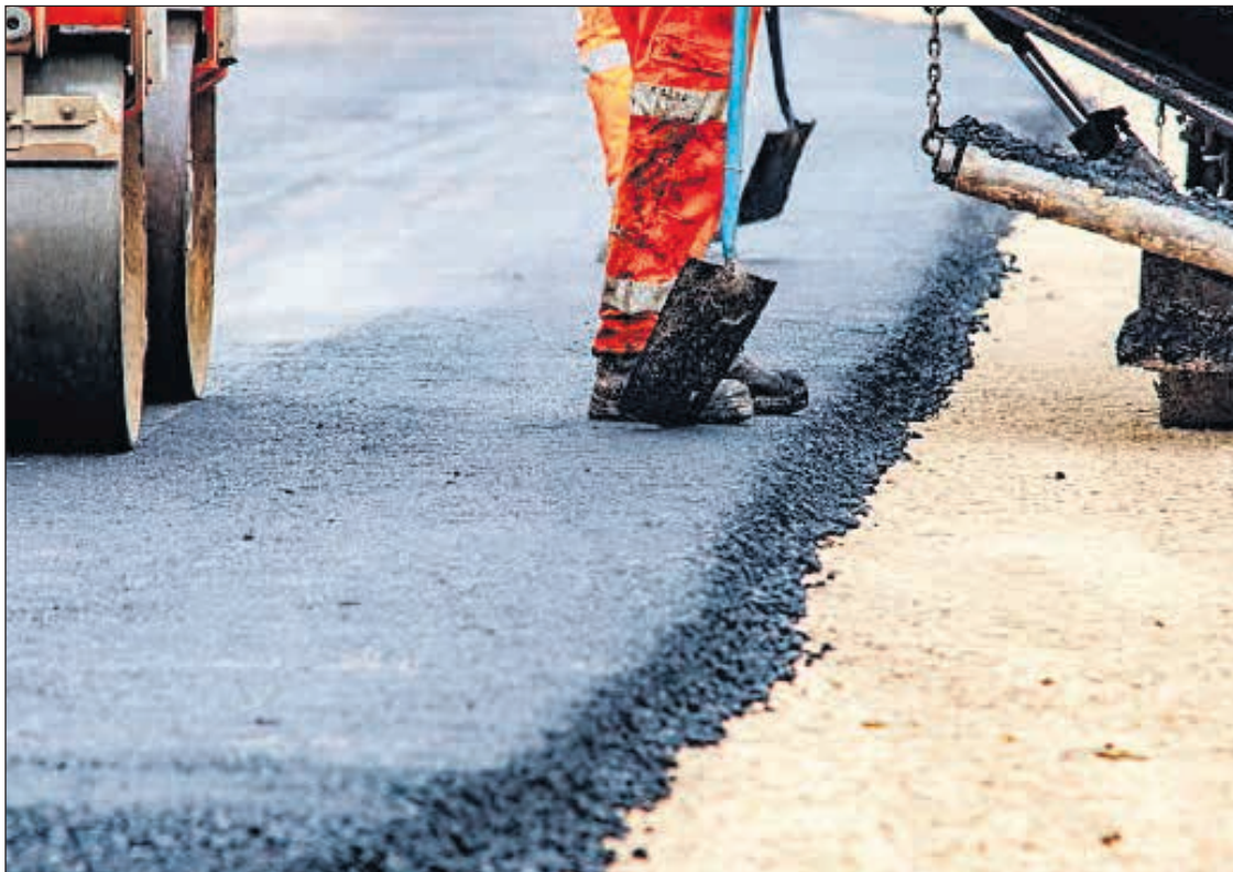
Operario asfaltando una calle
