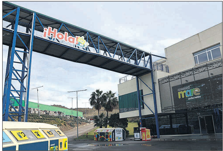
Planta de tratamiento del consorci
