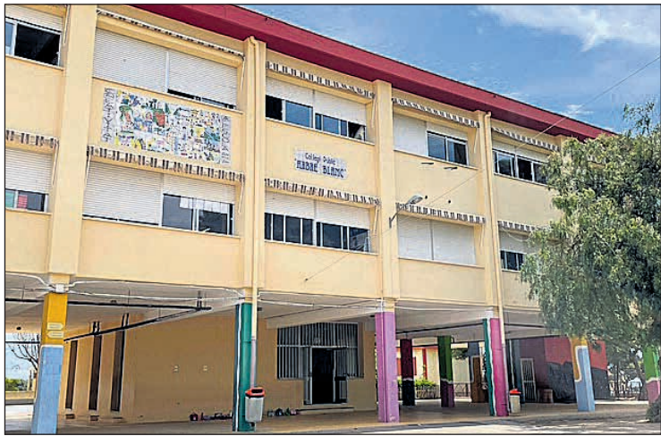
Fachada del CEIP Arbre Blanc
