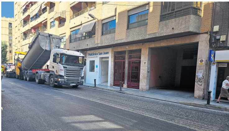
Máquinas en los trabajos de reasfaltado de calles
